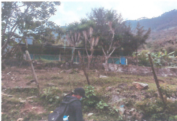
Foto 3: REMOZAMIENTO DE MURO DE CONTENCIÓN
