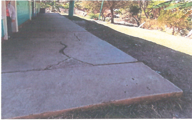
Foto 1: REMOZAMIENTO DE PISO
