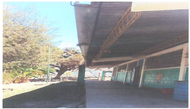
Foto 2: REMOZAMIENTO DE BAJADA DE CANALES PLUBIALES
